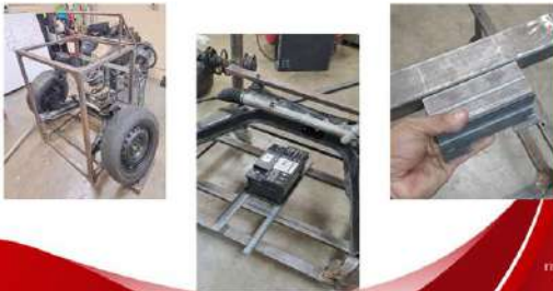
Proceso de construcción.
