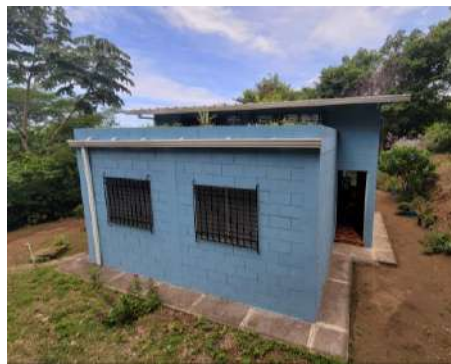
Fachada posterior vivienda bioclimática.
