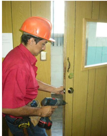
Proceso de instalación de la chapa eléctrica.
