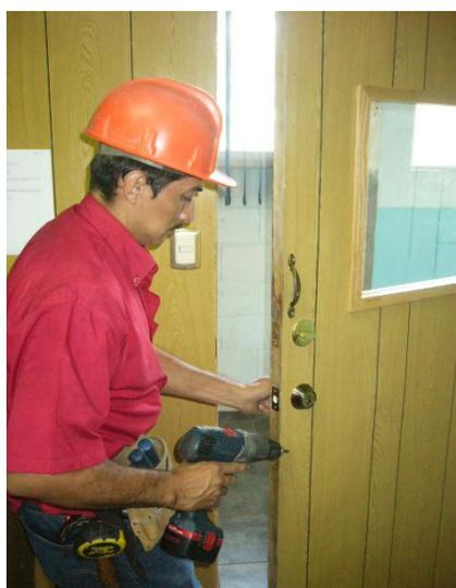
Proceso de instalación de la chapa eléctrica.
