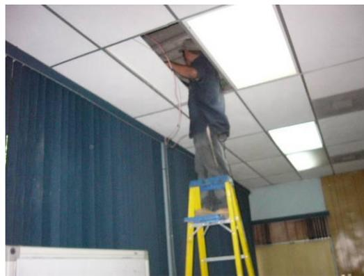
Instalación de la red eléctrica y nodos de conexión a la red LAN de los lectores RFID de la primera célula.
